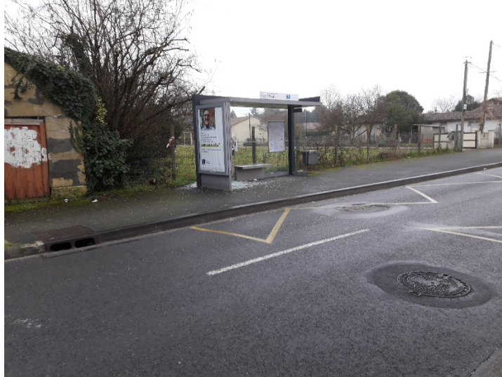
Réseau de gestion des eaux pluviales -Rue du Treuil
