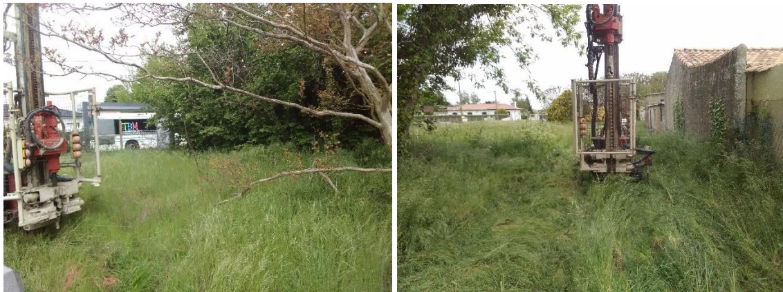
Vues du site le jour de notre intervention (lots 1 et 2)
